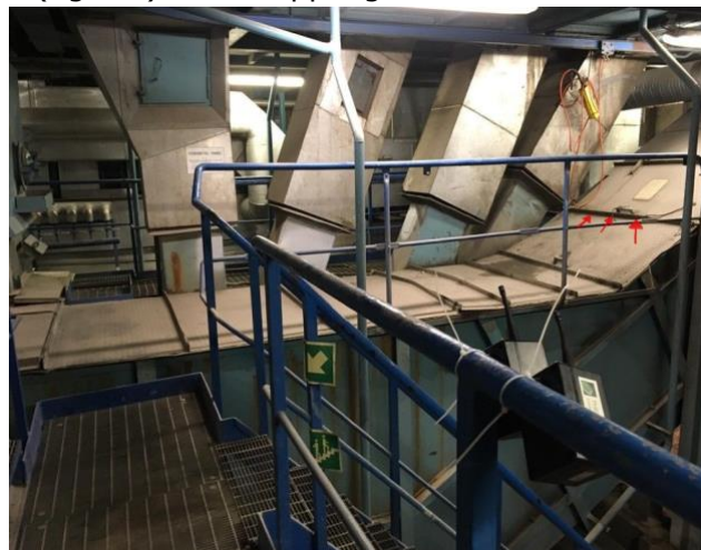
Figur 5: Utette luker ved slaggutmaterbåndet på linje 2.
