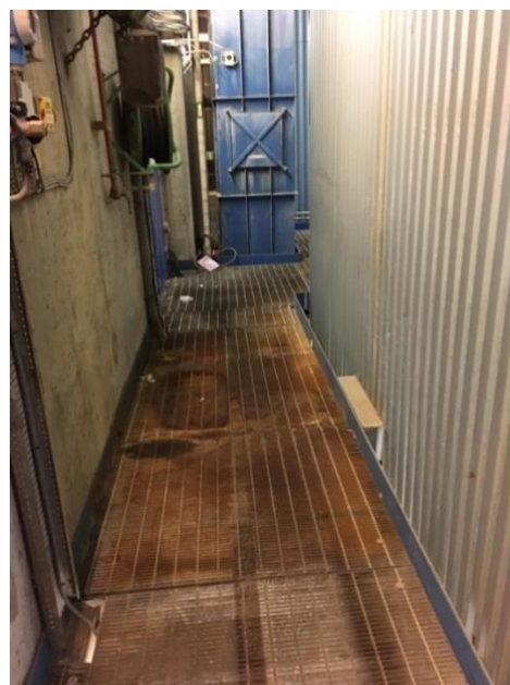
Figur 7: Korrosjon, gangparti mellom linje 1 og linje 2 på nivå 6.
